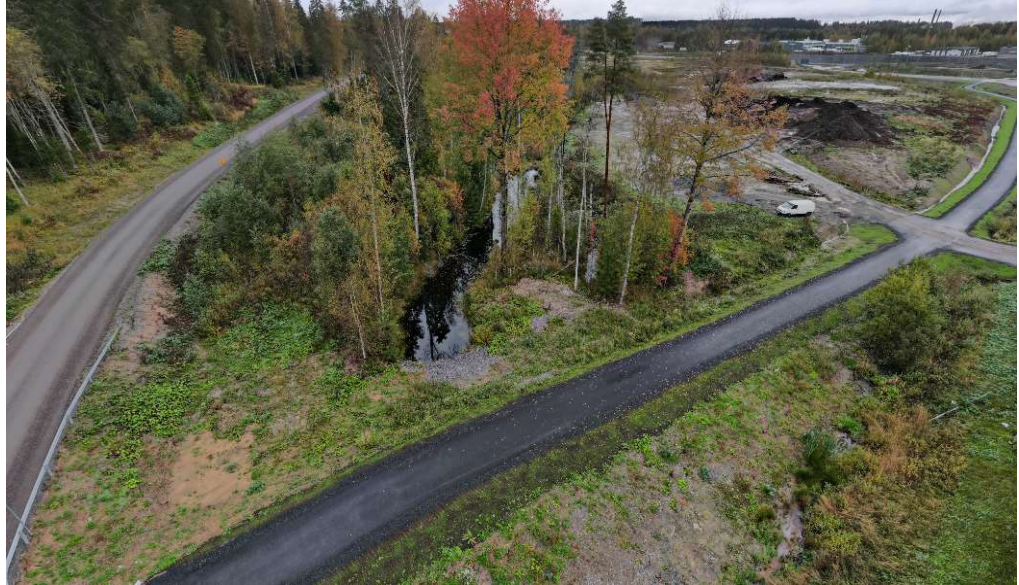
Kuva 10. Suunnittelualueen eteläreunalla sijaitseva Häijääntien ja jalankulku- ja pyöräilyväylän allittava rumpu, jonka kautta pintavesiä virtaa suunnittelualueelle etelän suunnasta. Kuva © Destia Oy 10/2023.
