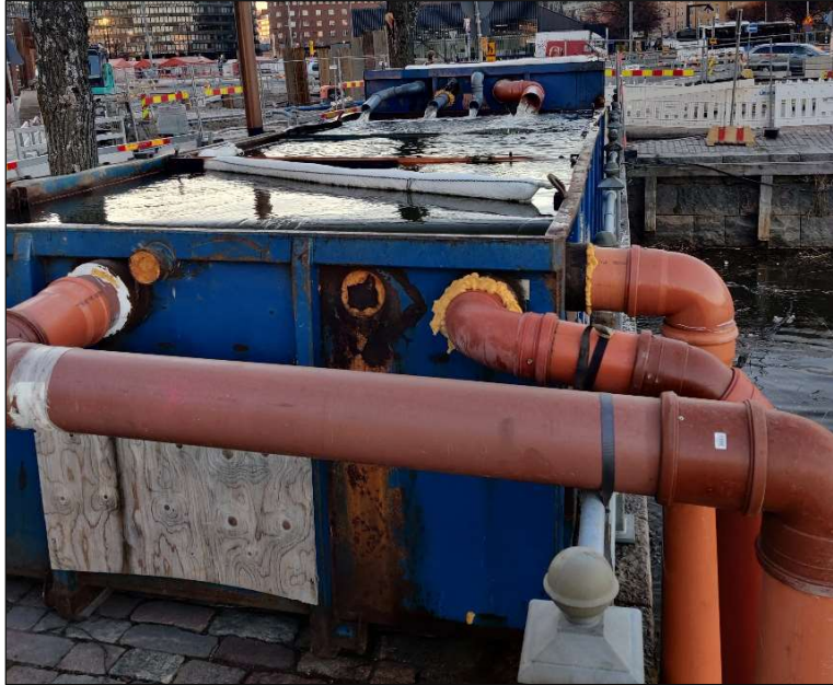
Kuva 19. Hulevesien työmaan aikaiseen viivyttämiseen ja suodattamiseen käytettävä vesitiivis laskeutuskontti. Konttiin pumpataan vedet työmaan kaivannosta. Konytiin on toteutettu väliseiniä hidastamaan veden virtausta ja edistämään kiintoaineksen laskeutumista. Järjestelmässä on kaksi konttia peräkkäin. Jälkimmäiseen konttiin ohjataan vedet ensimmäisen kontin pinnalta. Kuva © Destia 2024.
