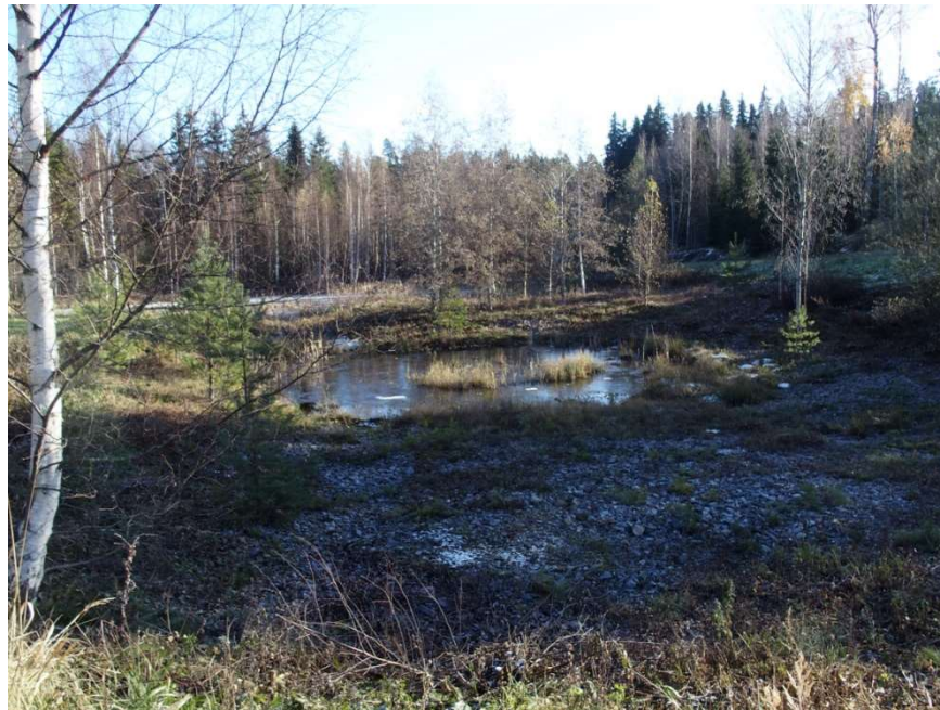
Kuva 18. Esimerkki hulevesialtaista Tampereelta. Mäyränmäen asuinalueen hulevesien hallintaa varten on toteutettu kolmen peräkkäisen altaan järjestelmä. Ensimmäisessä altaassa ei ole pysyvää vesipintaa. Kuvassa etualalla näkyvän keskimmäisen altaan pysyvän vesipinta-alan suuruus on noin 150 m 2 ja kuvassa takana näkyvän viimeisen altaan pysyvän vesipinta-alan suuruus on noin 800 m 2 . Altaisiin on muodostunut luontaista kosteikkokasvillisuutta. Kuva © Destia Oy 2024.
