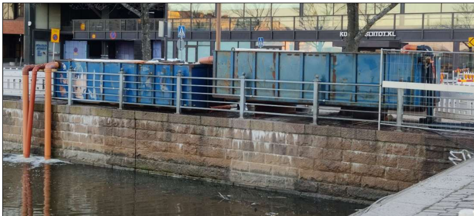
Kuva 20. Hulevesien työmaan aikaiseen viivyttämiseen ja suodattamiseen käytettävä laskeutuskontti. Vedet tulisi johtaa mahdollisuuksien mukaan kasvillisuuspainanteeseen. Purkuvesien suodattamisen parantamiseksi purkupäähän (kasvillisuuspainanteeseen) voidaan asentaa esimerkiksi tarvittaessa vaihdettava suodatinkangas tai väliaikainen suotopato. Kuva © Destia 2024.
