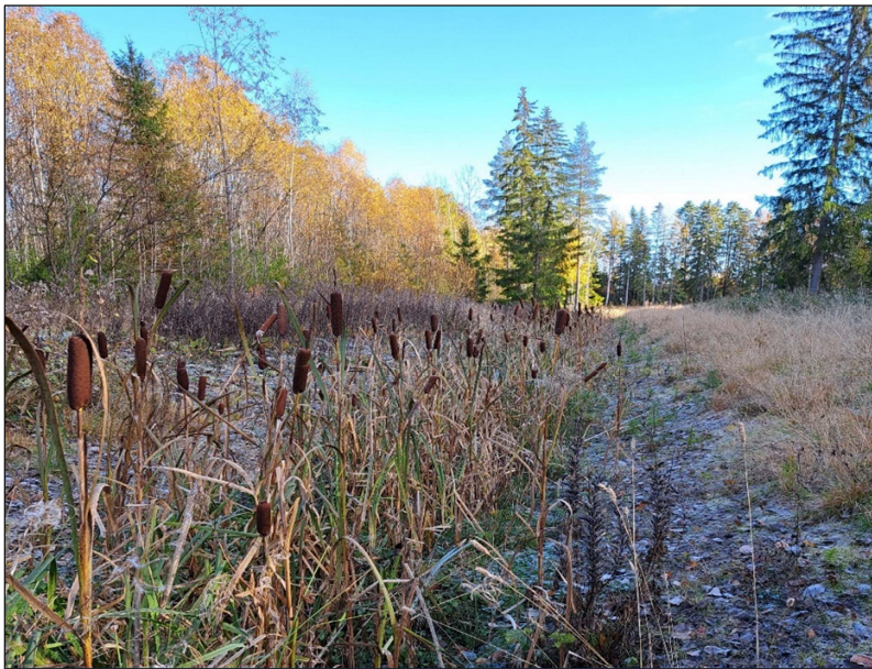
Kuva 16. Esimerkki tulvauomasta Järvenpäästä, kuvaussuunnassa on iso teollisuusalueen hulevesien viivytysallas. Uomaan on toteutettu pohjapato ennen purkaa hulevesialtaaseen ja uoman luiskien eroosiosuojaus on toteutettu pienlouheella. Uoman pohjalla oleva kasvillisuus hidastaa veden virtausta. Kuva © Destia Oy 2024.
